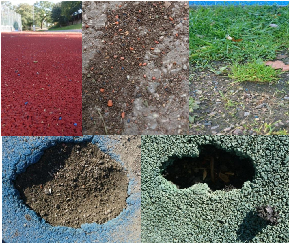
Figur 11. Lösa granulatbitar på och i nära anslutning till anläggningar av gjutet gummigranulat (övre bilder), samt exempel på skador i fallskyddsytta (nedre bilder).
